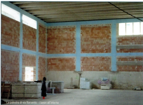
La palestra di via Barsento - i lavori all'interno
